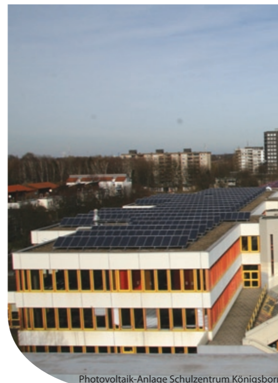
Photovoltaik-Anlage Schulzentrum Königsborn
