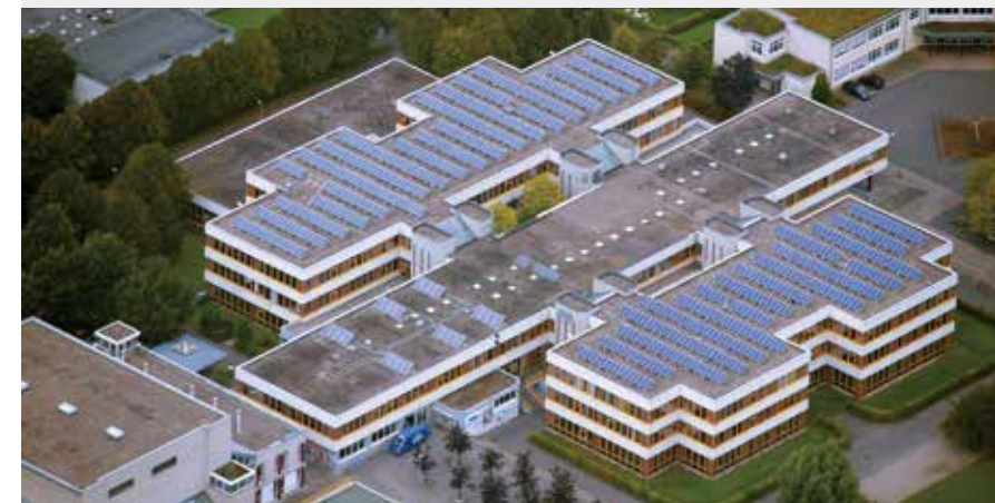
Auf vielen Schulgebäuden wie hier im Schulzentrum Königsborn arbeiten PV-Anlagen.
