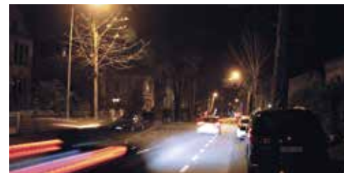
Sparen mit LED-Lampen in der Straßenbeleuchtung: Seit 2011 haben wir den Verbrauch um über ein Drittel reduziert.
