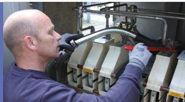
Das Team der 10-kv-Netzabteilung kontrolliert und reinigt die Trafostationen: Siegmund Schmidt, Andreas Jabs, Ralf Bethke und Dennis Knop.
