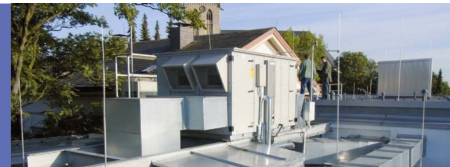
Energiecheck auf dem Dach des Verlagsgebäudes der Unnaer Zeitung. Die Analyse des täglichen Lastganges und der Verbrauchsspitzen zeigt Effizienzchancen.
