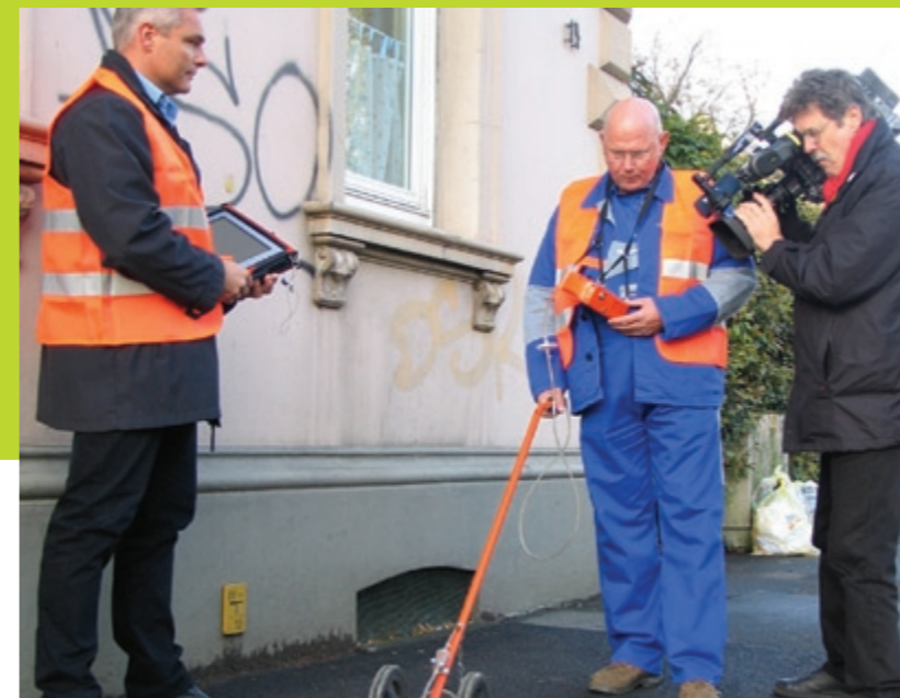
Regelmäßig überprüfen wir alle Gasleitungen auf mögliche Leckstellen. Ortsnetzstationen werden kontinuierlich erneuert.
