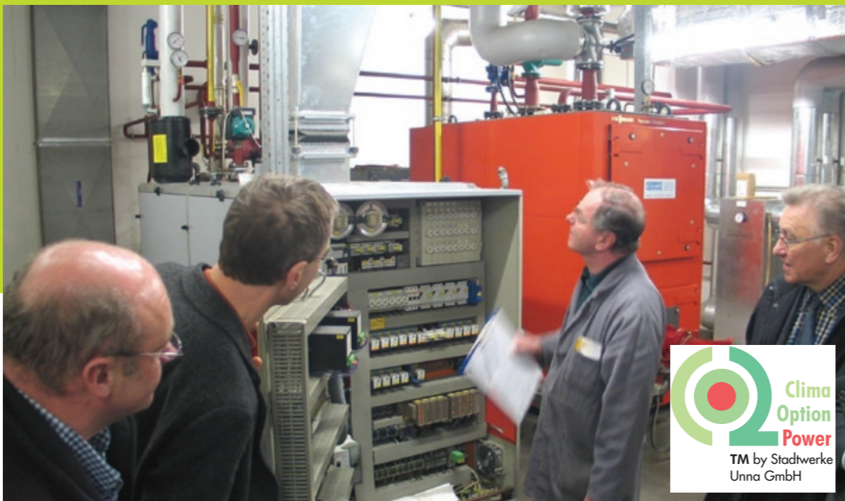
Kleine Blockheizkraftwerke wie etwa hier im Hotel Katharinenhof können für viele Kunden eine Alternative zur Heizung sein.
