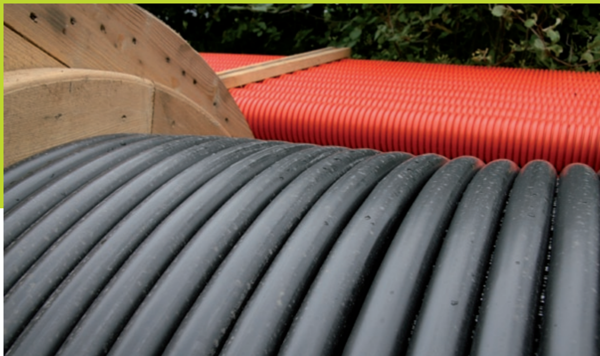
Störungsanfällige Strom- und Gasleitungen in den Ortsteilen wechseln wir komplett aus.
