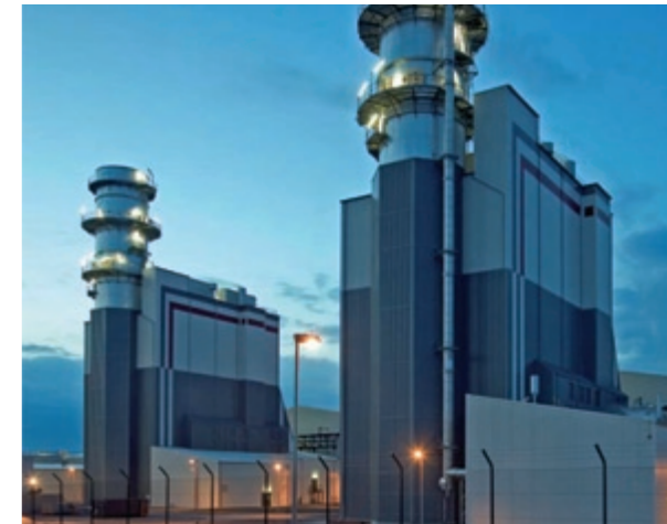
Gas- und Dampfturbinenkraftwerk in Hamm-Uentrop. ↓
